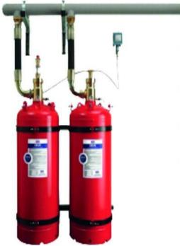
سیستم‌های اطفاء حریق FM200 معمولاً در موارد زیر استفاده می‌شوند: مراکز داده، اتاق‌های UPS، امکانات پزشکی، الکترونیک، تجهیزات پزشکی، تجهیزات تولید، کتابخانه‌ها، اتاق‌های مدارک پزشکی و بایگانی‌ها، اتاق سرور، ایستگاه‌های پمپاژ نفت، محفظه موتور، اتاق‌های مخابرات، اتاق سوئیچ، فضاهای موتور و ماشین آلات، اتاق‌های پمپ، اتاق‌های کنترل.
